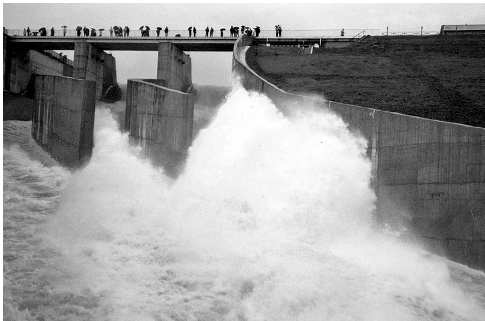
Fot. 1. Powódź na Dunajcu w 1997, przelew na zaporze pod Niedzicą, 9.07.1997 r. (Fot. K. Karwowski)
